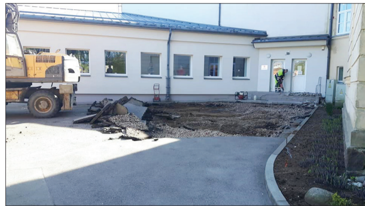
Līdz šim esošā asfaltbetona sega tika izbūvēta pagājušā gadsimta astoņdesmitos gados un savu laiku jau bija krietni nokalpojusi.
